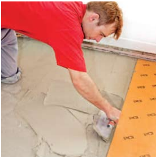
Na pripravený podklad naniesť PCI Nanoflott® light alebo PCI Rapidflott® ...
