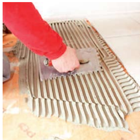
a s PCI Nanoflott® light alebo PCI Rapidflott® položiť novú keramickú podlahu.
