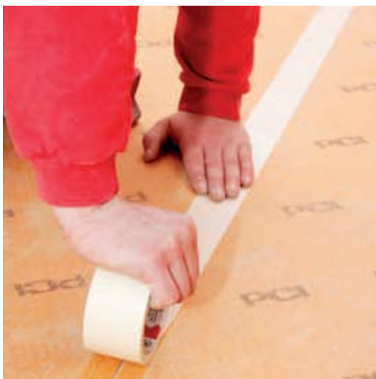
V suchých priestoroch prelepiť spoje krepovou lepiacou páskou, v priestoroch zaťažených vlhkosťou utesniť s PCI Pecitape®...
