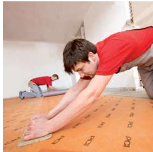
Položiť PCI Pecilastic® U a pevne pritlačiť, napr. drevenou latou alebo latou z tvrdenej peny.
