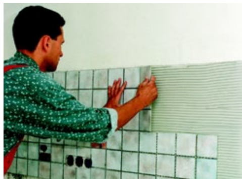
Obklad sa nezošmykuje a je možné ho určitý čas vyrovnávať.
