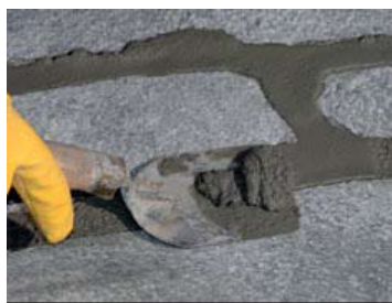
Prebytočnú hmotu odstrániť tvrdým gumeným hladidlom alebo špachtľou.
