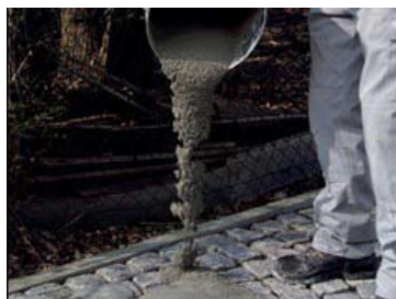
Nanášanie PCI Pavifix® CEM na plochu, ktorá sa má škárovať.
