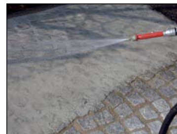
Aby sa pri čistení dlažobných kociek zamedzilo vyplavovaniu hmoty zo škár, je potrebné prúd vody viesť takmer horizontálne na povrch.
