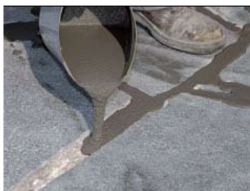
PCI Pavifix® CEM naliať pomocou vhodnej nádoby do pripravených škár.
