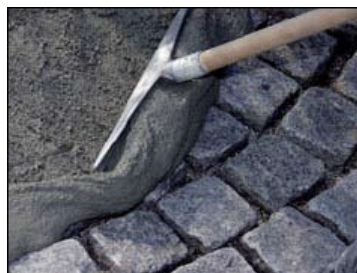
Pri metóde stierkovaním sa PCI Pavifix® CEM ľahko vtláča do škár gumeným hladidlom.
