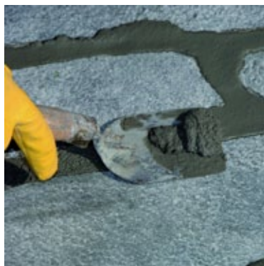
Po zavädnutí malty (skúška prstom) odstrániť nadbytočnú maltu špachtľou.
