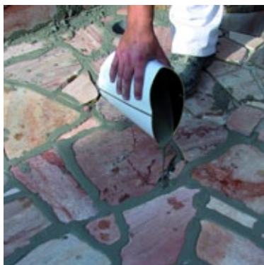
PCI Pavifix® CEM Rapid naliať pomocou vhodnej nádoby do pripravených škár.
