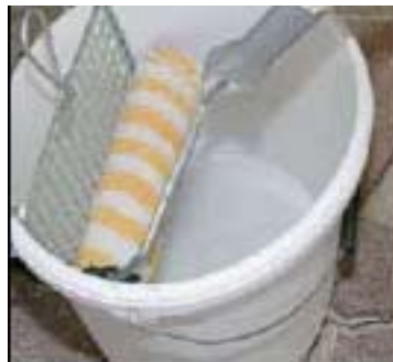
Prebytočný materiál sa pred aplikáciou odstráni pomocou mriežky..
